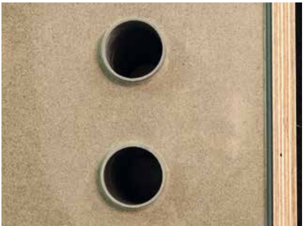
Optimale Verdichtung auch um Leitungspakete oder Rohre
