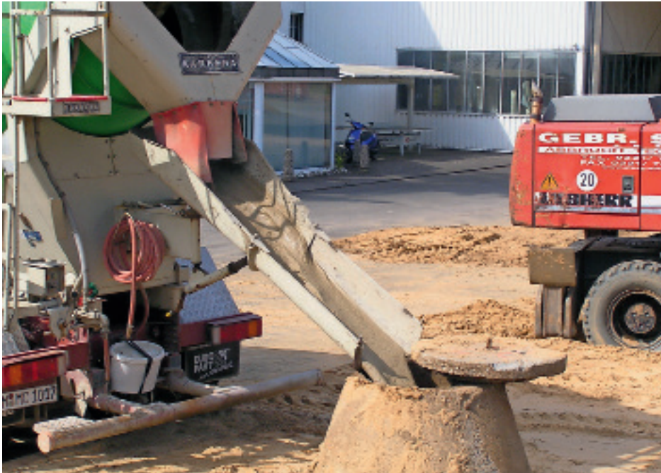
Abbildung 1: Flüssigboden ist fließfähig und selbstverdichtend.
