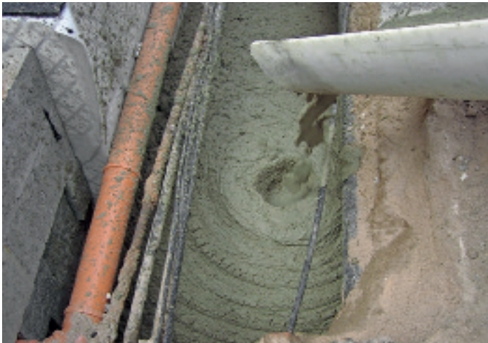
Abbildung 3: Der Baustoff verteilt sich gleichmäßig und verfüllt auch Hohlräume
